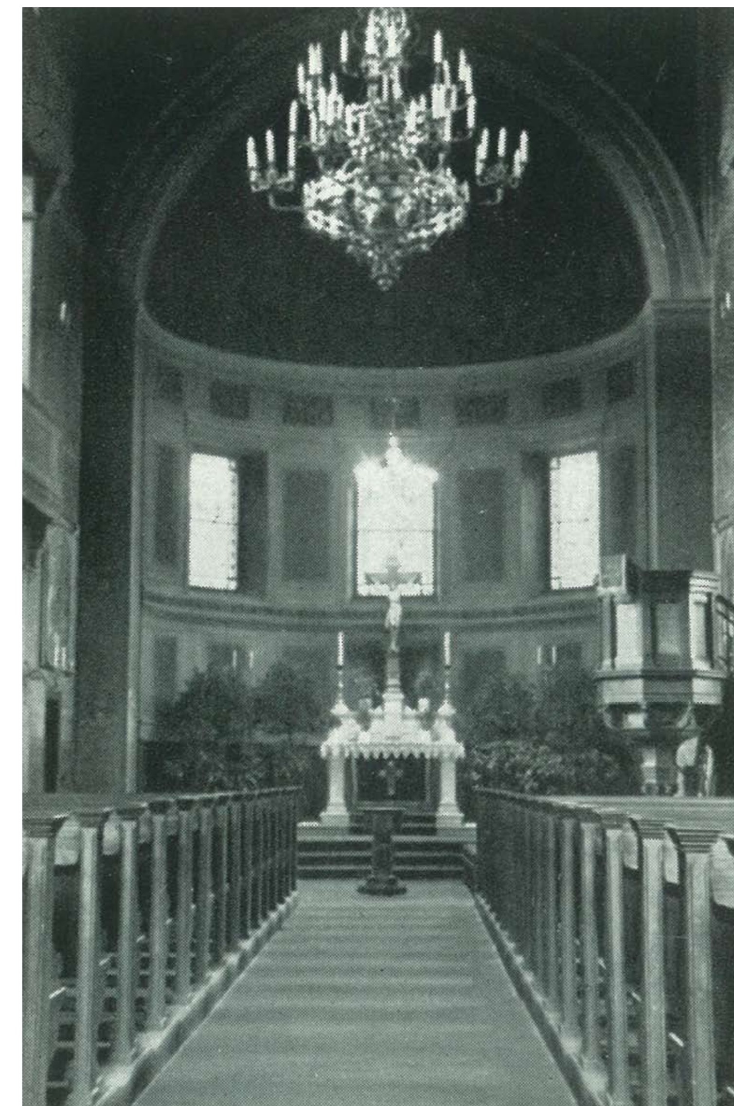
Altarraum von St. Elisabeth vor der Instandsetzung
