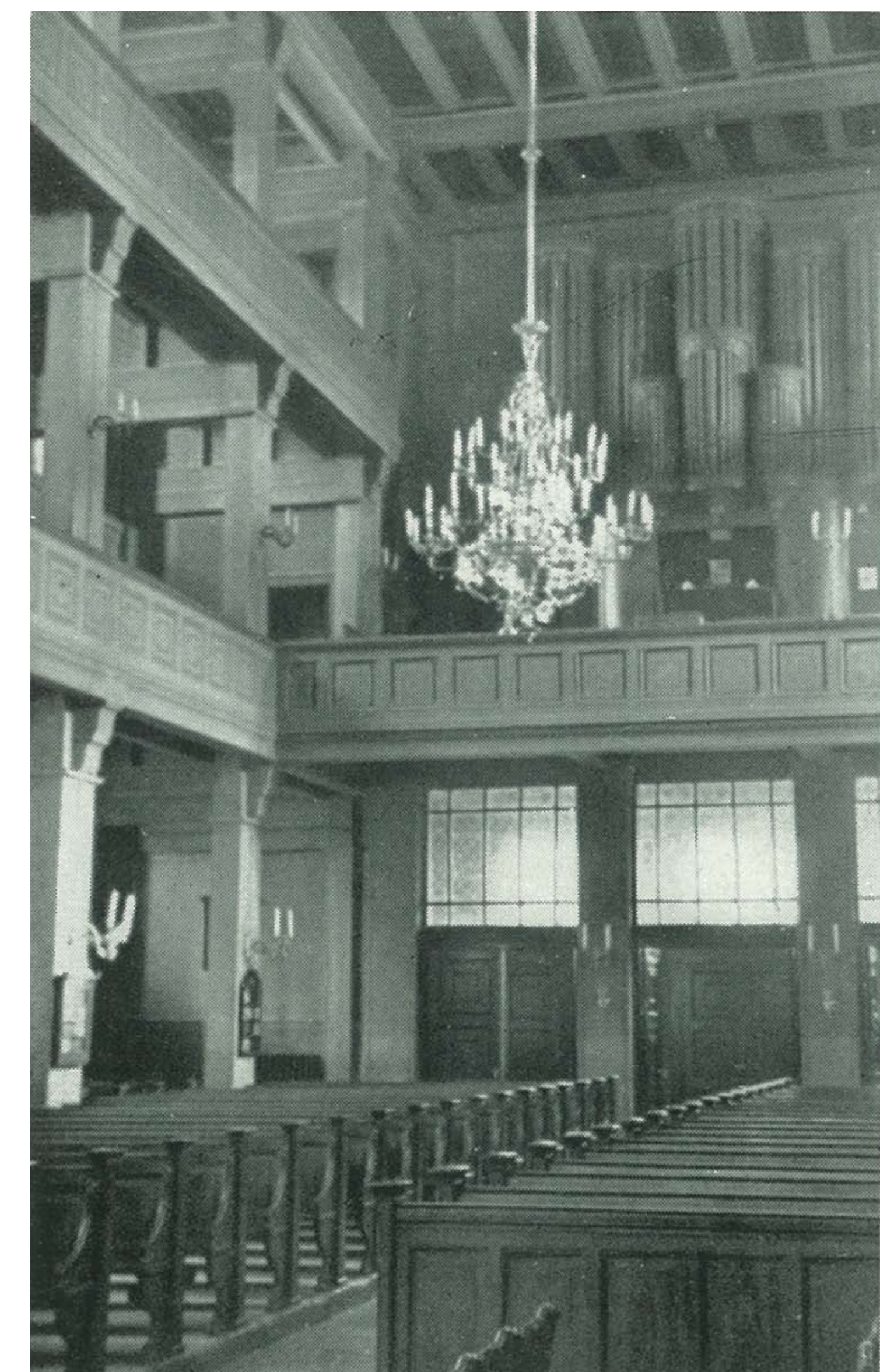
Orgelempore von St. Elisabeth vor der Instandsetzung
